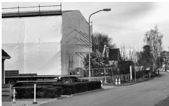
Een bijzondere verschijning aan de Oude Rijksweg in Garmerwolde: in verband met de versterking is de woning helemaal ingepakt (foto Sieb-Klaas Iwema)
