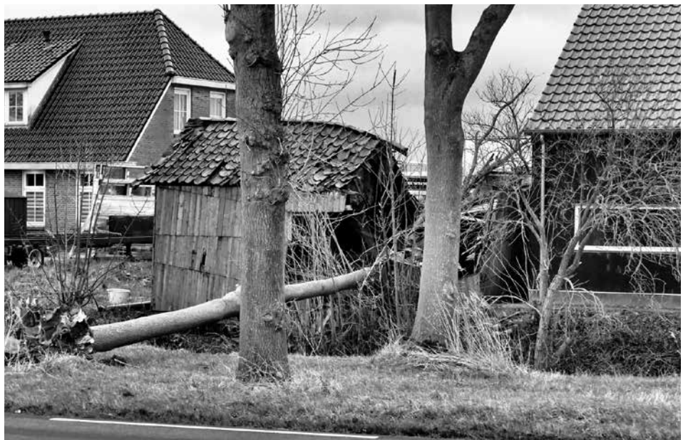
Stormschade aan het schuurtje naast Dorpshuis de Leeuw (foto Sieb-Klaas Iwema)
