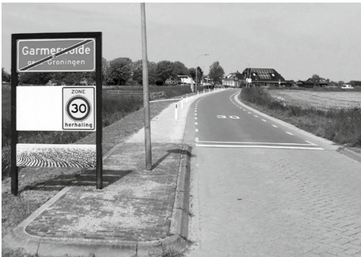
Het voetpad langs de Dorpsweg vanaf het plaatsnaambord naar de Stadsweg (het gedeelte buiten de kern) is klaar en door flexibele berm paaltjes gescheiden van de rijbaan (foto Harjo de Poel)
