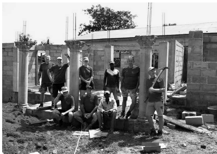
De muren, gemetseld door de bouwgroep, staan als een huis (eigen foto)
