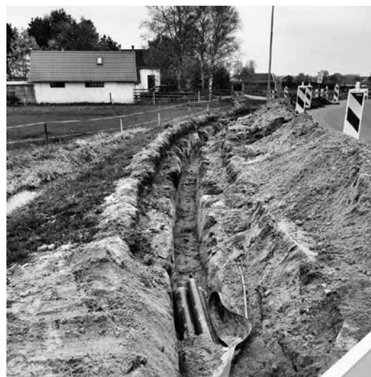
Er worden drie nieuwe stroomdraden van de Fledderboschweg naar een trafo bij de rioolwaterzuivering gelegd. Dit houdt in dat het wandelpad voorlopig weg is, maar het bedrijf Verkley (dat het werk uitvoert) moet het weer opleveren in de staat zoals het was. (foto Sieb-Klaas Iwema)
