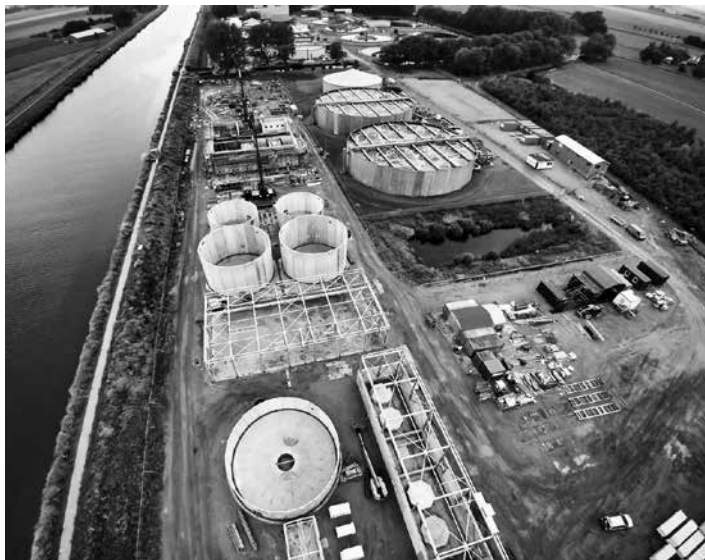
Overzicht in dronevlucht van de industriewaterzuivering in aanbouw (foto Sieb-Klaas Iwema)
