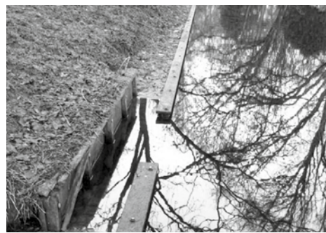
Een in-/uittredeplaats in het Eemskanaal (foto Noorderzijlvest)
