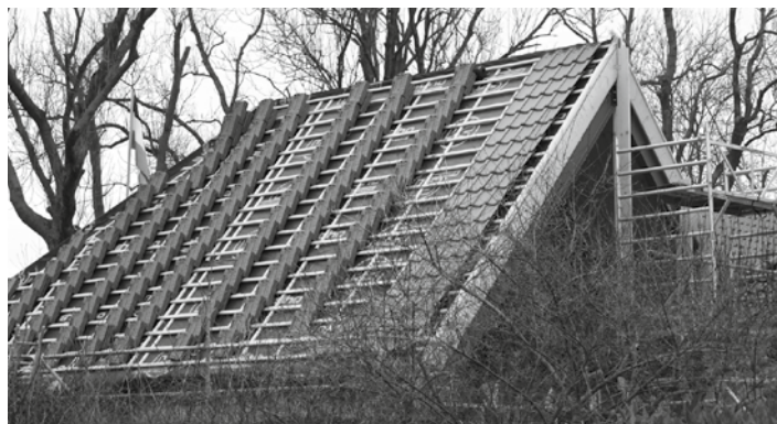
De pannen liggen klaar om gelegd te worden (foto foto Sieb-Klaas Iwema)
