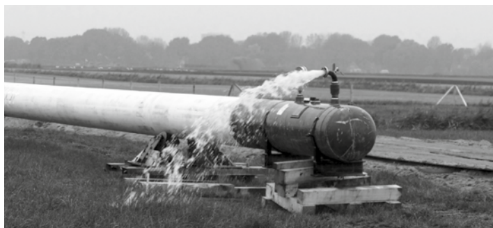
De nieuwe drinkwatertransportleiding wordt getest (foto Sieb-Klaas Iwema)
