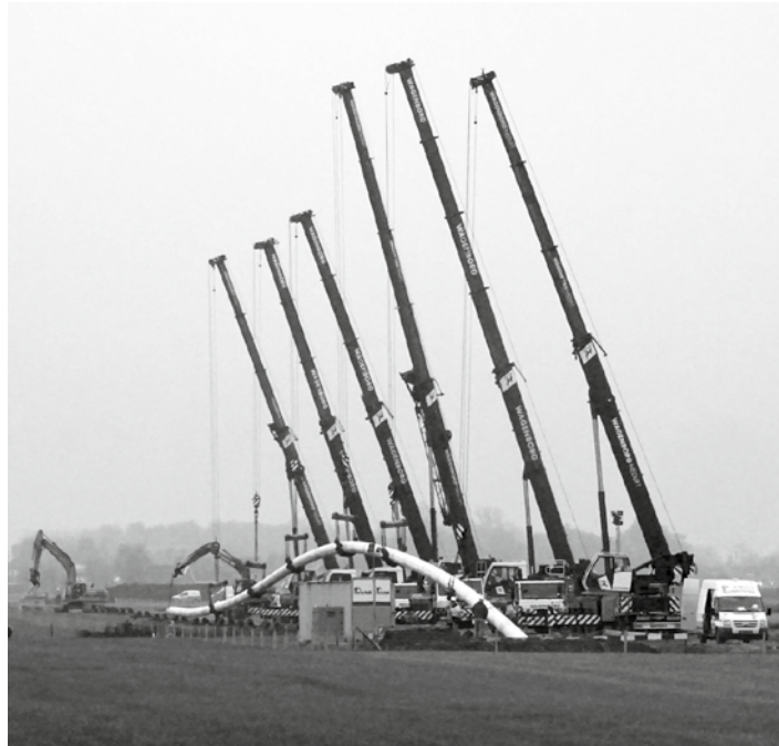
De lange witte waterleidingbuis hing in zes telescoopkranen (foto Andries Hof)
