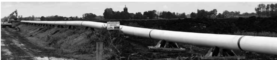
Een lange streng buizen voor de nieuwe drinkwaterleiding ligt klaar (foto en tekst Sieb-Klaas Iwema)
