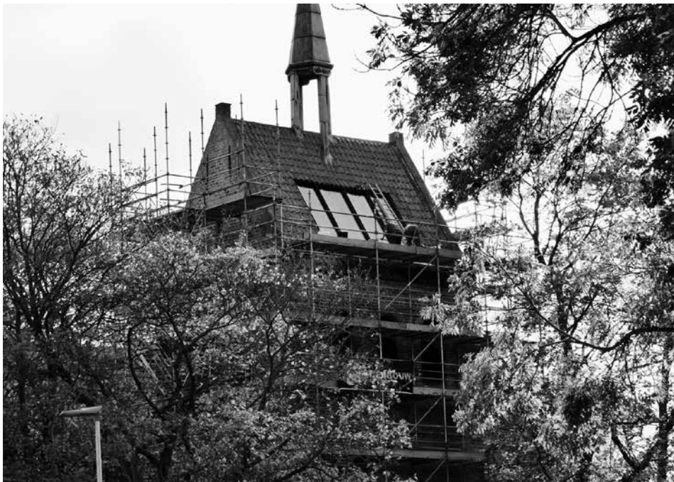
Het grote raam is in het dak van de kerktoeren geplaatst (foto Sieb-Klaas Iwema)
