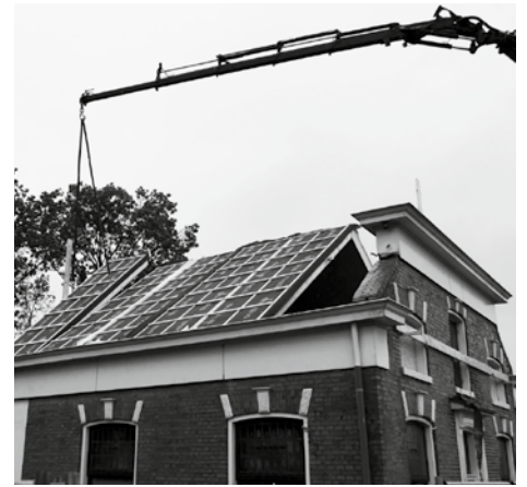
Het voorhuis van De Leeuw wordt voorzien van een nieuwe kap (foto Sieb-Klaas Iwema)
