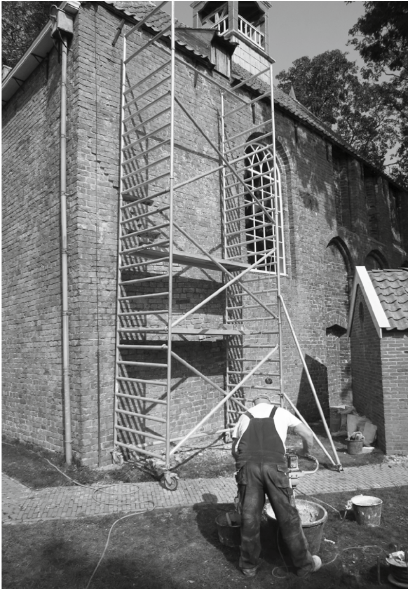
In 1973 is er onder de gescheurde zijmuren van de Kloosterkerk in Thesinge een betonnen fundament gestort om verder verzakken te voorkomen. De scheuren waren echter nooit 'gerepareerd', alleen opgevuld met specie. Daar heeft men nu Boonstra Bouwservice uit Nieuw Weerdinge voor ingehuurd. U ziet Steve Moore (een Engelsman die al meer dan dertig jaar voor de Brexit naar Nederland is gekomen) aan het werk. De stenen boven en onder de diagonale scheur zijn er een voor een uitgenomen en er opnieuw weer ingemetseld met iets meer specie erboven en eronder. (foto Jan Ceulen)
