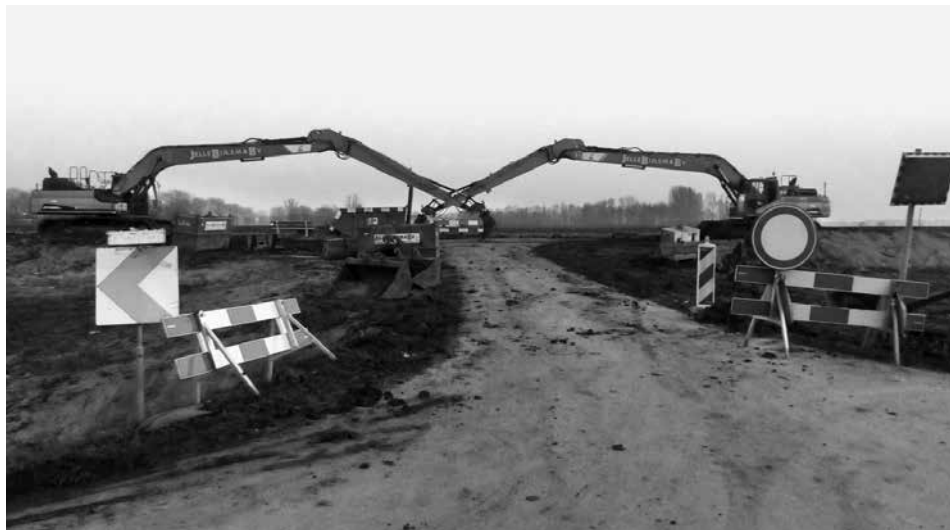
Het asfalt wordt verwijderd (foto Sieb-Klaas Iwema)
