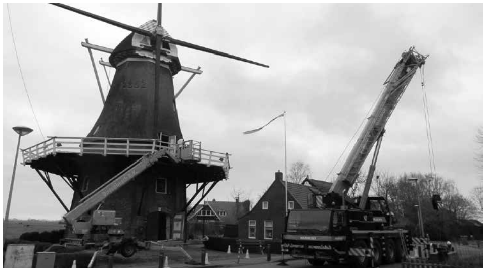
Met behulp van groot materieel werden de roeden van de Germania verwijderd (foto Jan Mollema)
