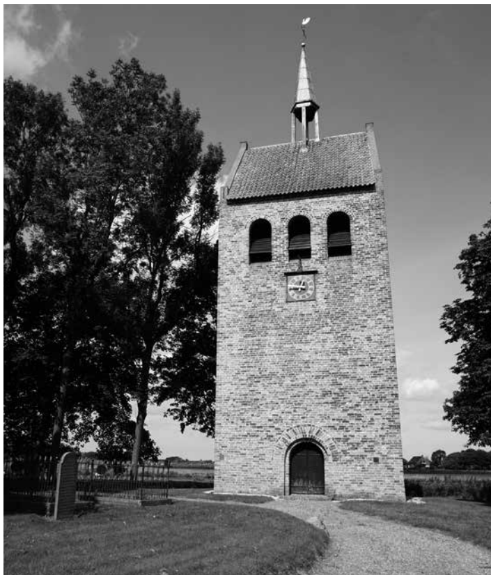
De zuidzijde van de toren met op de achtergrond de Stadsweg (foto Yvonne Broekhuizen)
