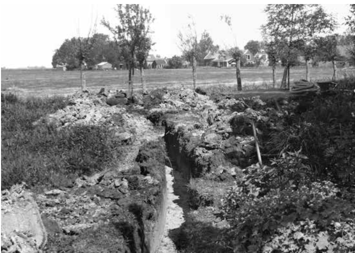
Vorbereidingen voor de drainage op de plek waar...
