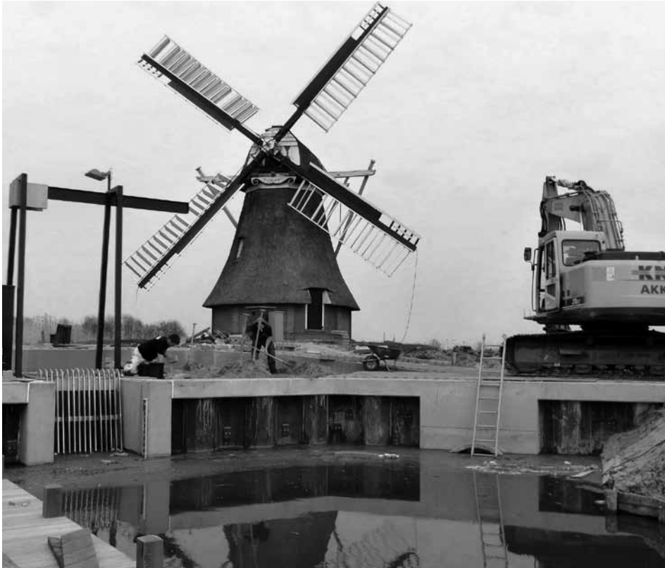
De laatste werkzaamheden aan het gemaal (foto Sieb-Klaas Iwema)
