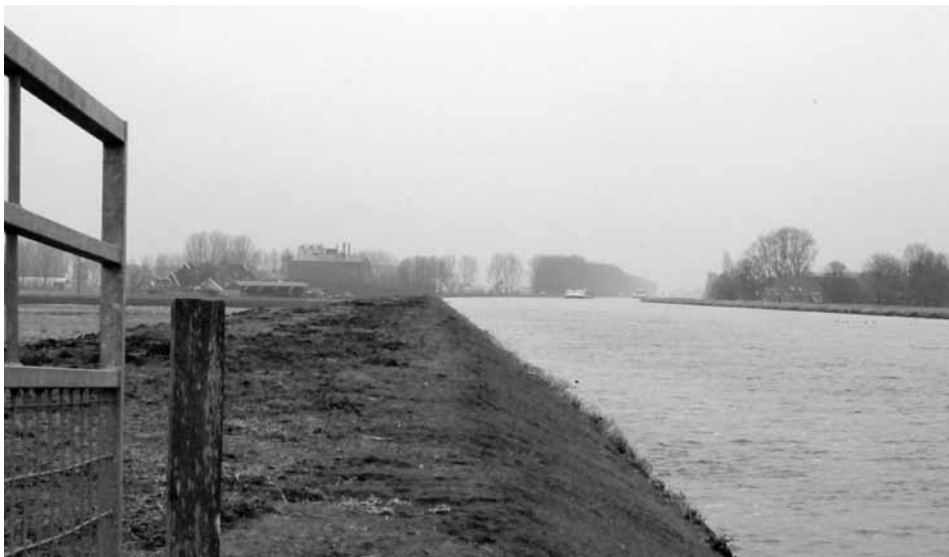
Erosiebestendige kleilaag op de Eemskanaaldijk (foto: Freek Mandema)
