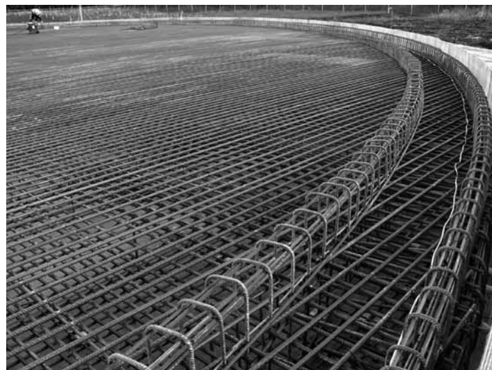
Het kunstwerk van betonijzer is inmiddels onder het beton verdwenen (foto: Sieb Klaas Iwema)
