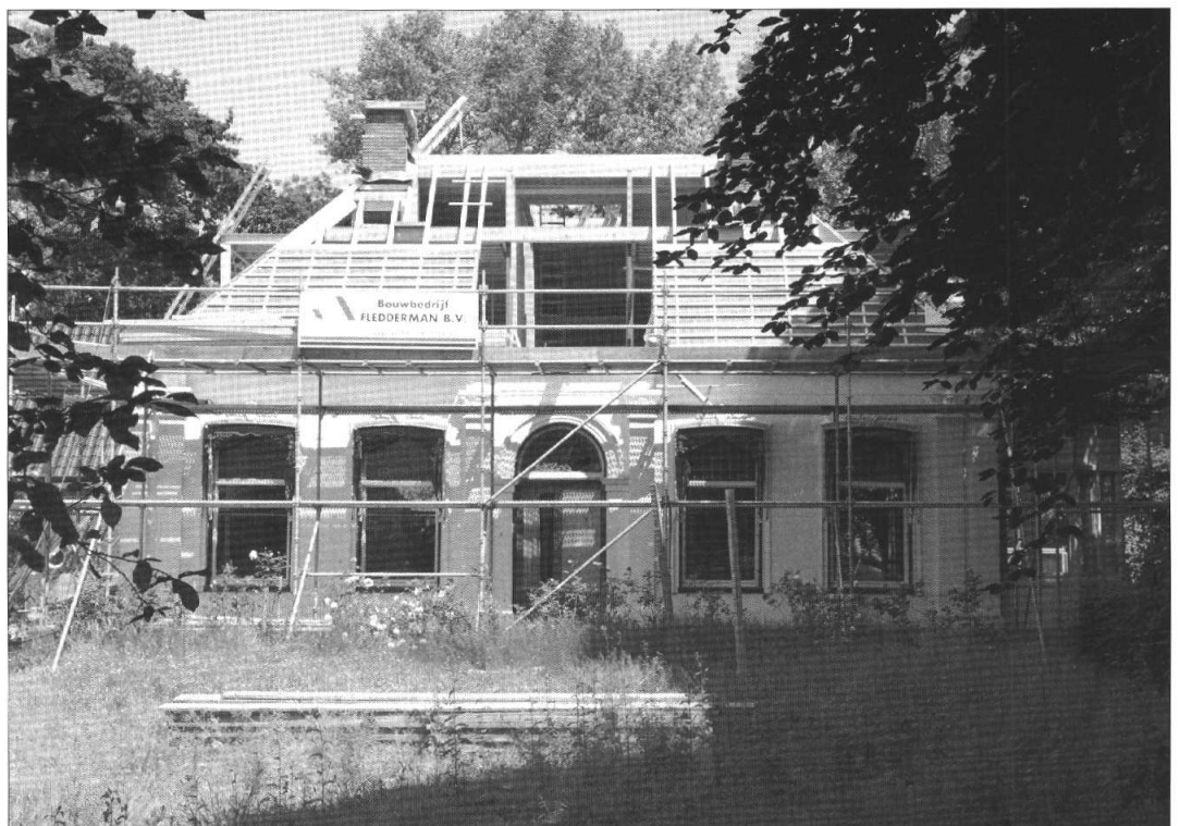
... en mét dakopbouw. (Foto's: Henk Remerie)
