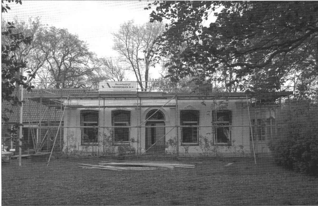
De vorderingen van de herstelwerkzaamheden aan het doktershuis; zónder dak ...
