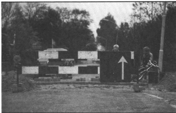
wegversperring voor de aanleg van de plateaus in de Schutterlaan (foto: A. v.d. Meulen)
