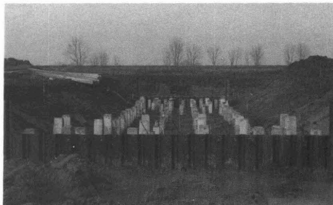
Sluis Damsterdiep-Eemskanaal in aanbouw
