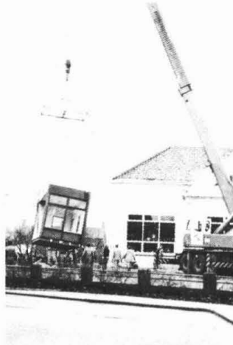
Het hijsen van het lokaal over de school in Garmerwolde
