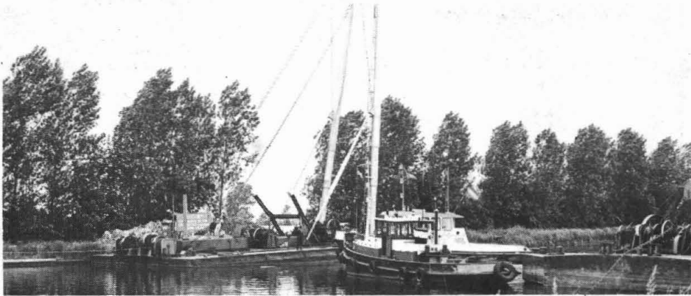
Met groot materieel en met assistentie van kikvorsmannen werd op zondag 11 juni j.l. de persleiding voor de zuiveringsinstallatie te Garmerwolde onder het Eemskanaal gelegd.
