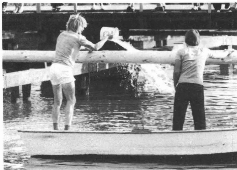
Erst wordt de paal nog even lekker glad gemaakt...
